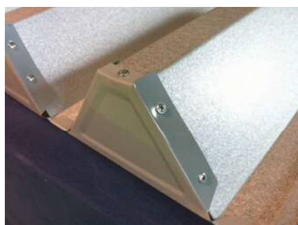
面戸の取付け
